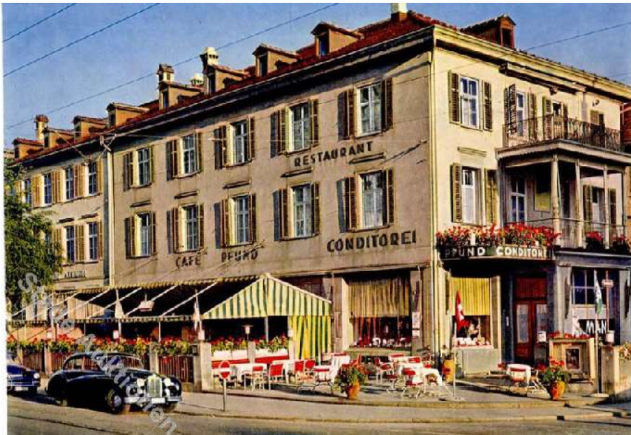
Ehem. Café-Rest. Pfund, Bahnhofstr. 9, 9000 St. Gallen
